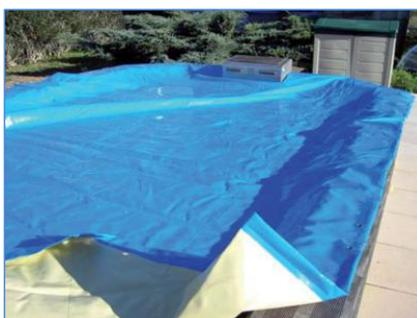
**3 – Visser les crochets inox sur la paroi de la piscine, au milieu de chaque paire d'œillets et 40cm sous le bord extérieur de la couverture.**
