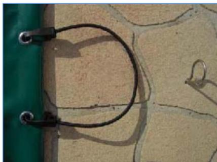
**2** Positionner le piton dans le sandow et l'insérer dans le trou.
